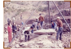
대구 구암동고분군 56호분 본분 개석 제거 작업
